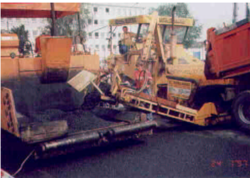
Abb.2: Beschickung des Deckschichtfertigers mit Übergabegerät
